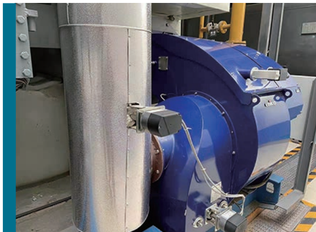
▲ 空調燃燒器更換
